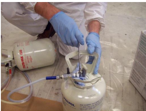
Tee mutka letkuihin ja irroita säiliö.
